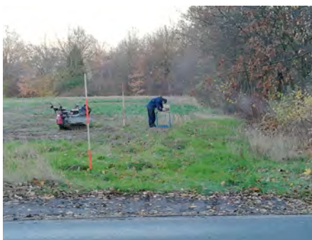
Hier entsteht das neue Wohngebiet Nievenheimer Straße
